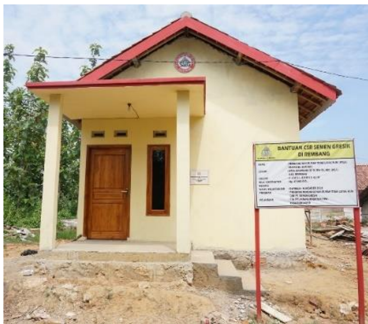
Gambar 3: Bedah Rumah di Timbrangan (Sumber: Dokumentasi Peneliti)
