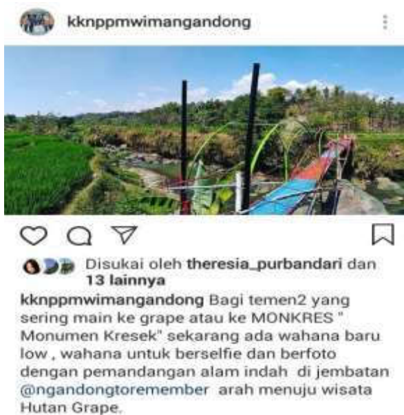
Gambar 2. Pembenahan Jembatan Sesek Dukuh Ngandong
